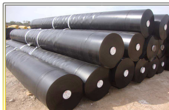
Acopio de materiales de impermeabilización
