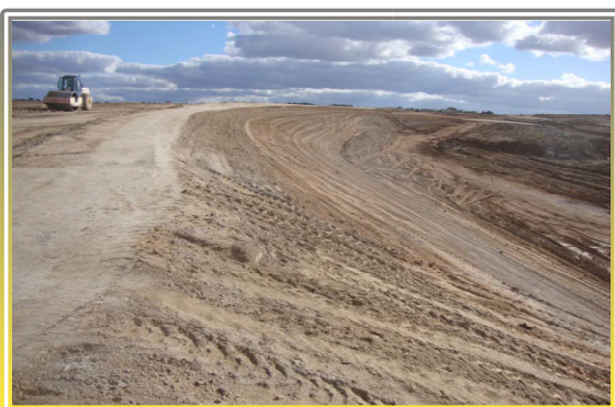
Acondicionamiento de terraplenes
