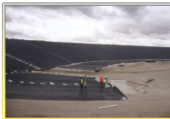
Avance lámina de impermeabilización
