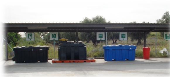
Contenedores de residuos peligrosos
