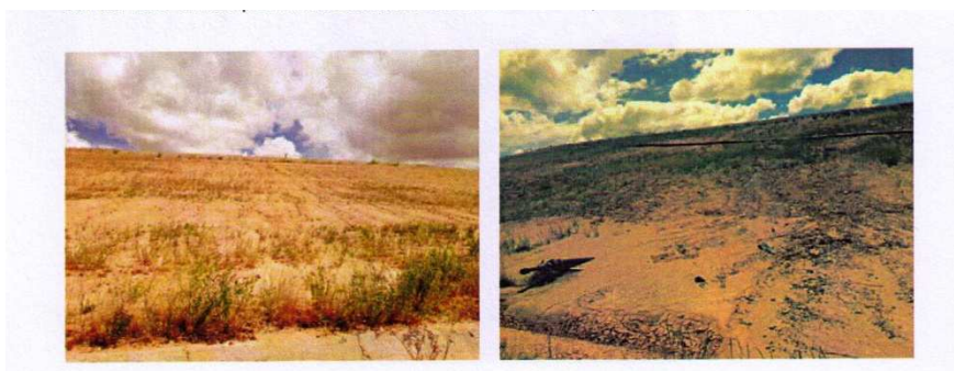
Zonas de fallos en la hidrosiembra por las lluvias
