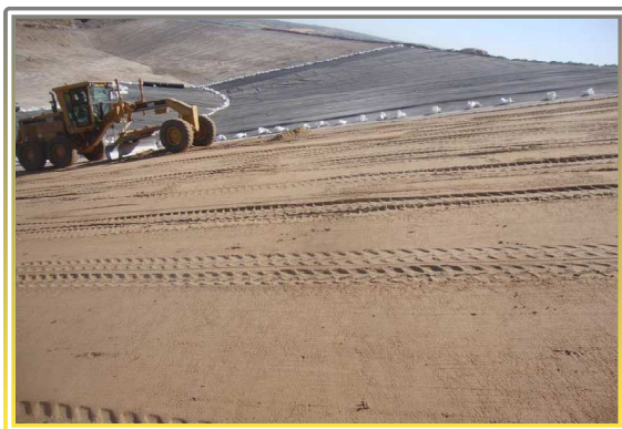
Aplicación de material específico en terraplenes
