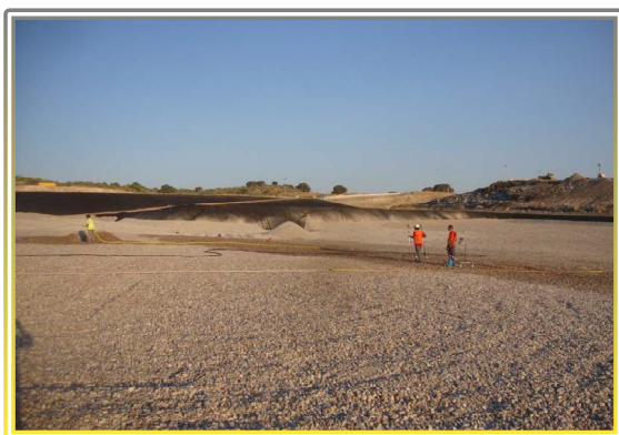
Ensayo de seguridad por el método geo-eléctrico
