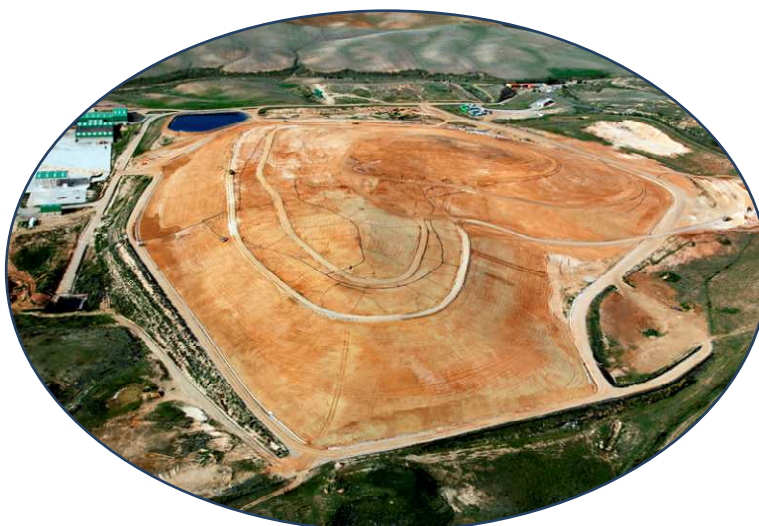
Estado actual del Antiguo Depósito controlado de residuos de Toledo clausurado
