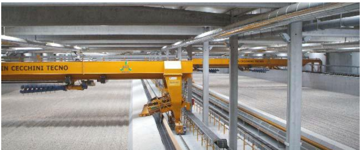
Interior de la nave de compostaje del Ecoparque Toledo con los dos reactores de maduración Sorain
