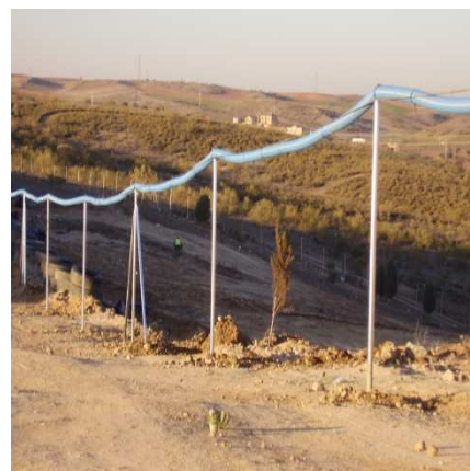
Sistema de neutralización de olores
