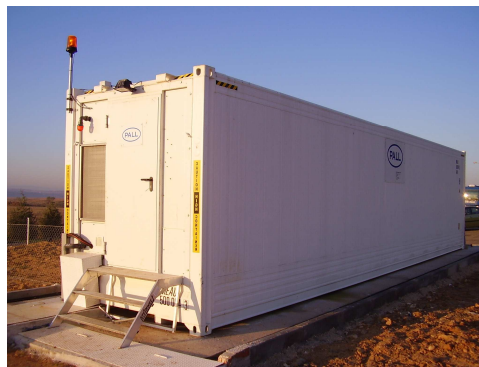
Depuradora de lixiviados
