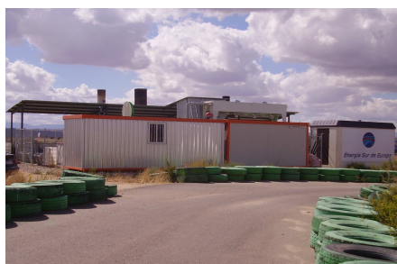
Estación de captación de gas
