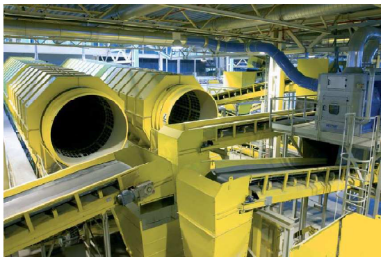
Vista parcial de una línea de pretratamiento
