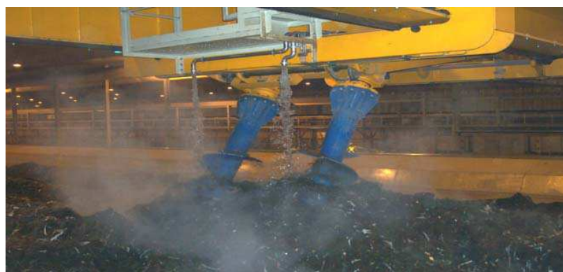
Tornillos del puente volteador del Reactor de compostaje
