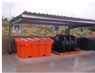
Contenedores de residuos peligrosos
