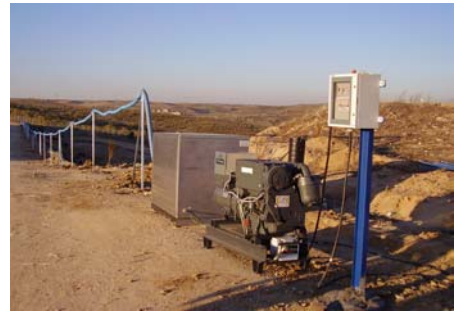
Sistema de neutralización de olores
