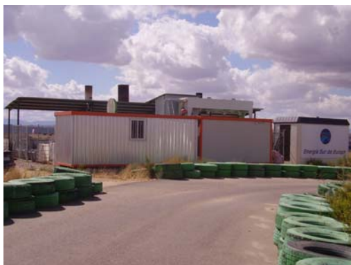
Estación de captación de gas
