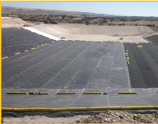
*Impermeabilización de la celda de vertido*
