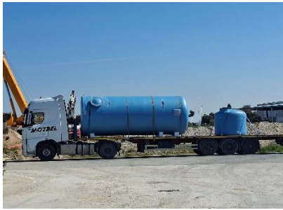
Recepción de depósitos de PRFV
