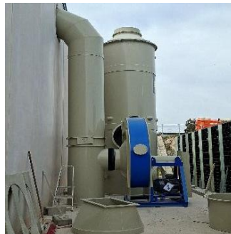
Colocación ventilador y tubería de aire Biofiltro
