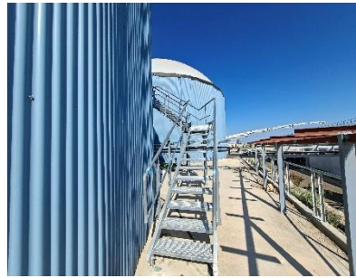
Escalera exterior para digestores
