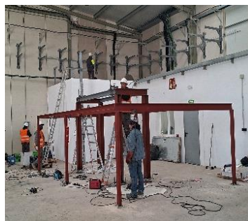
Construcción de estructura Centrifuga
