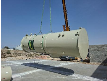
Llegada de la torre de biofiltro
