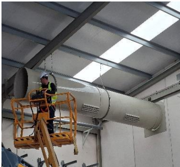
Colocación tubería de aire Biofiltro
