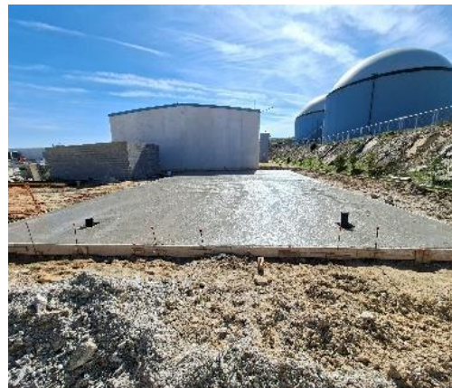
Construcción de solera de biofiltro.
