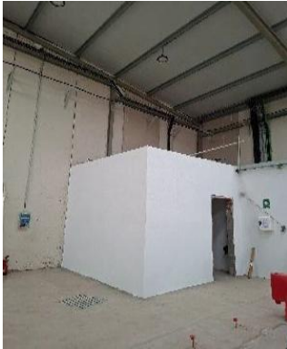
Terminación de caseta eléctrica
