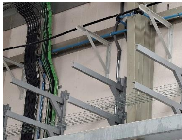
Estructuras de soporte de bandejas de tuberías y cableado
