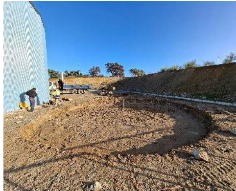
Excavación cimentaciones depósitos de biosuspensión y agua proceso
