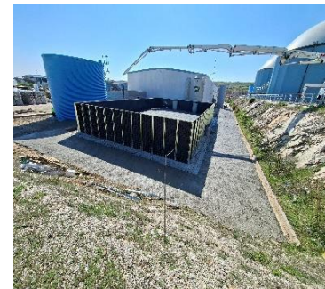
Implantación paredes Biofiltro terminación caseta bomba PCI
