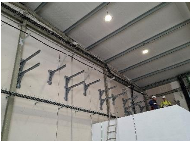
Estructuras de soporte de bandejas de tuberías y cableado
