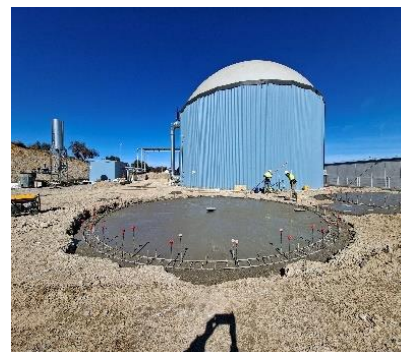
Ferralla y Cimentación de depósitos de biosuspensión y agua proceso
