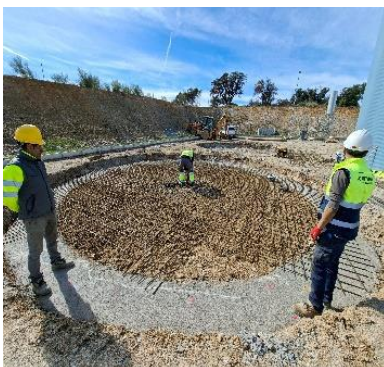
Hormigón de limpieza en depósitos de biosuspensión y agua proceso
