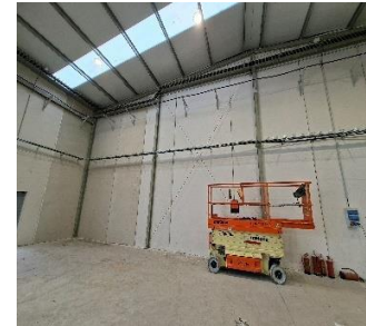
Instalación cableado electricidad
