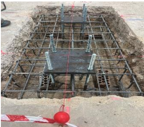
Construcción de zapatas de centrifuga
