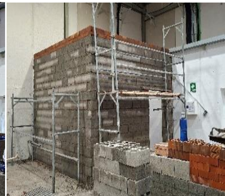
Construcción de la ampliación de caseta eléctrica.
