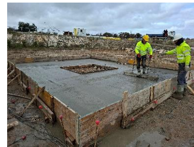
Hormigonado caseta bomba PCI
