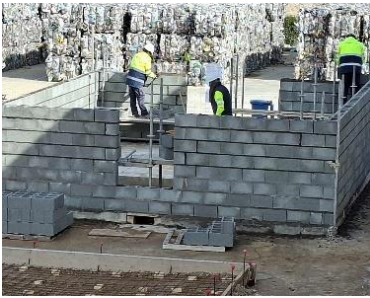
Construcción caseta bomba PCI
