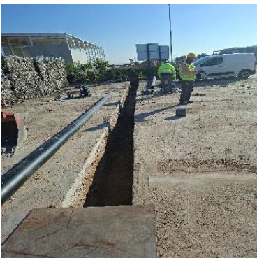
Zanja para conexión de PCI
