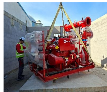
Colocación grupo bomba de PCI
