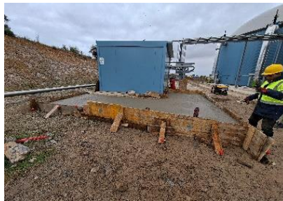
Hormigonado solera caseta caldera
