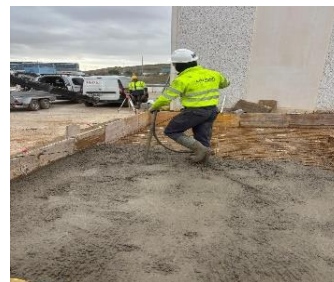
Colocación de mallazo y hormigón en solera de caseta de PCI
