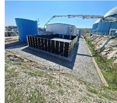
Terminación caseta de bomba y deposito de PCI
