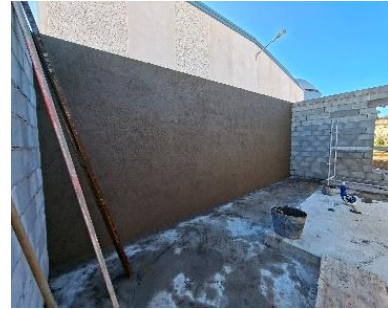
Enfoscado caseta bomba PCI
