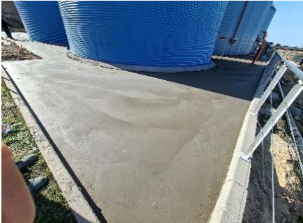
Hormigonado soleras recirculado Área de digestores
