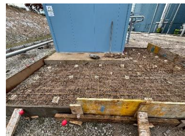
Colocación de mallazo en solera de caseta de madera
