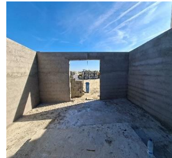
Enfoscado caseta bomba PCI
