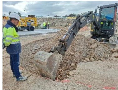
Excavación cimentación de deposito PCI
