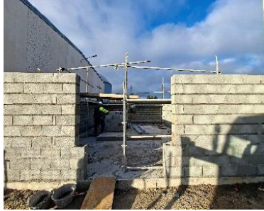
Construcción caseta bomba PCI
