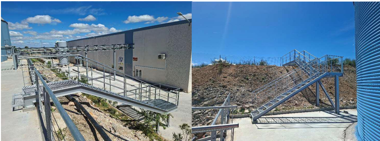
ESCALERA DE ACCESO DESDE LAS OFICINAS A ZONA DE BIOMETANIZACIÓN
