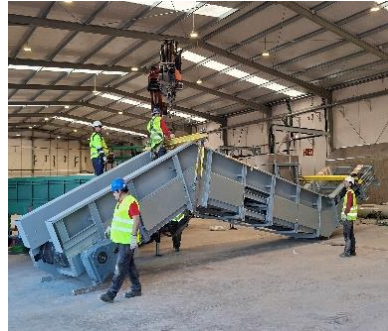
Instalación de cinta en abrebolso para nave Bio
