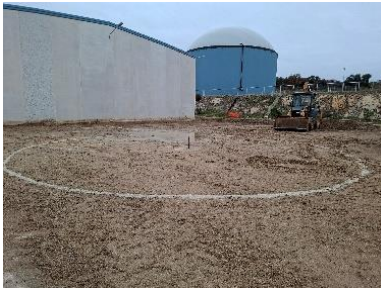
Replanteo solera caseta bomba PCI, solera depósitos PCI
