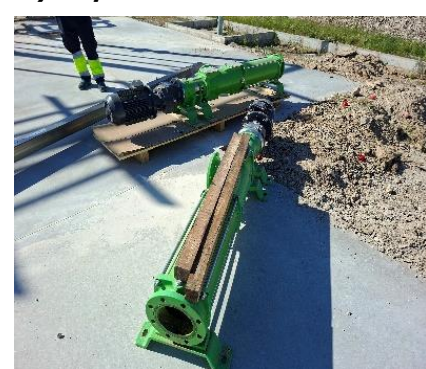
Colocación de bombas helicoidales
