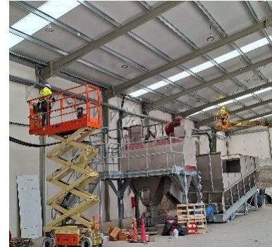
Instalación tuberías y cableado PCI
