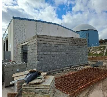
Construcción caseta bomba PCI
