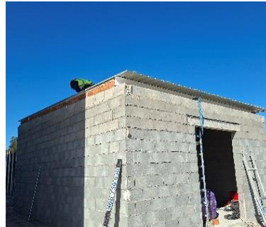
Colocación cubierta caseta de bomba de PCI
