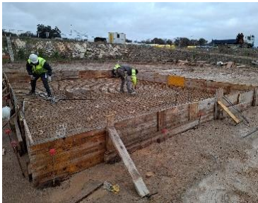
Preparación encofrado solera de caseta de PCI
