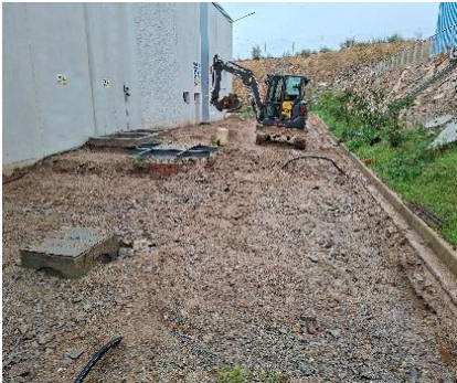
Trabajos de nivelación zona de Recirculado detrás de nave Bio
