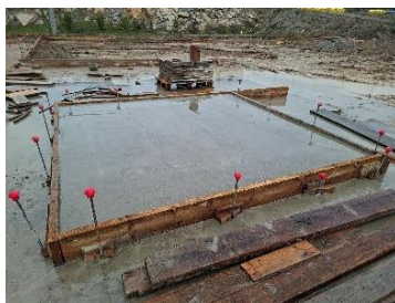
Hormigón banqueta solera de Caseta de bomba de PCI
