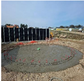
Hormigonado de cimentación de PCI
