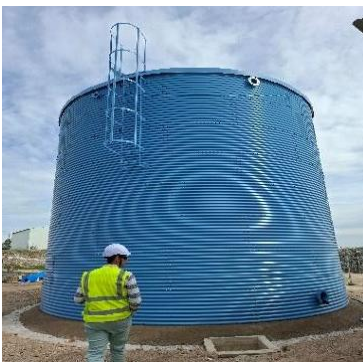
Colocación de depósito de PCI
