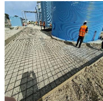
Colocación mallazo solera de recirculado
