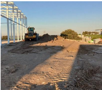
Inicio nivelación zona urbanización
