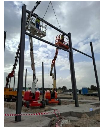
Suministro y montaje de pilares estructura metálica nave
