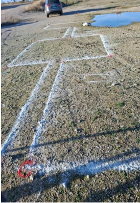
Replanteo de zanjas
