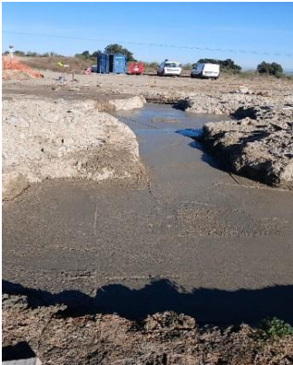
Continuación vertido de hormigón
