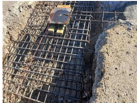
Nivelación y anclaje de placas en cimentación
