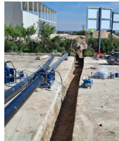
Apertura de zanja desde el grupo hasta nave textil
