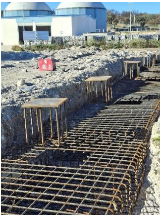
Nivelación de ferralla de cimentación y suministro de placas
