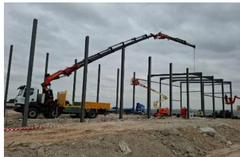
Suministro y montaje de pilares estructura metálica nave
