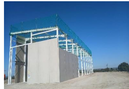
Inicio montaje prefabricado de hormigón perimetral
