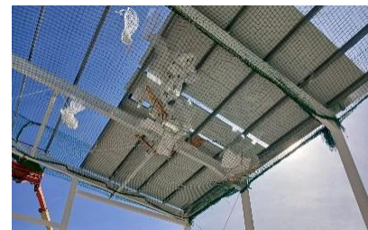
Montaje de cubierta
