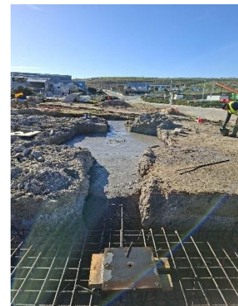
Inicio de vertido de hormigón de cimentaciones
