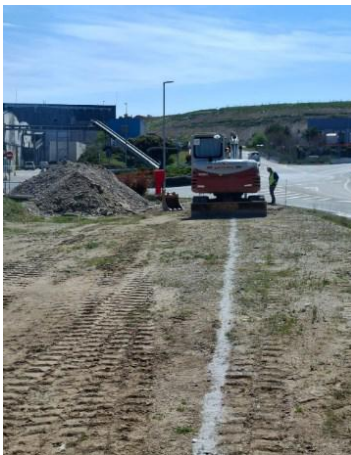
Replanteo zanja instalaciones
