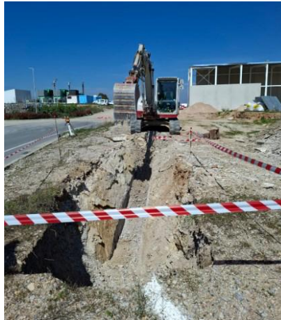
Excavación zanja instalaciones
