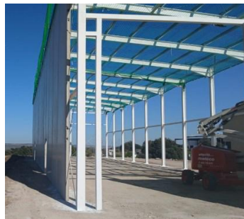
Fin montaje y pintura de estructura metálica nave.
