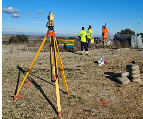
Replanteo y nivelación de cotas
