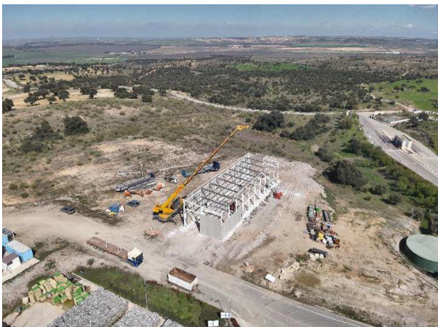
NAVE PLANTA TEXTIL: Movimiento de tierras, cimentaciones, estructura metálica, cubierta, cerramientos verticales exteriores y solera
