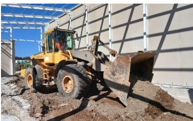
Nivelación zona solera interior y continuación montaje prefabricado perimetral
