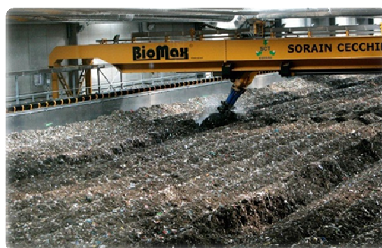
Nave de bioestabilizado
