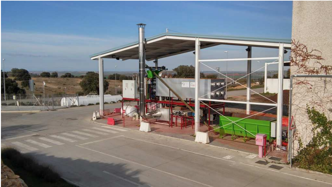
Vista general de la Planta de Biolíquidos
