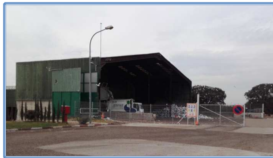
Zona de descarga de la planta de selección y transferencia de Talavera
