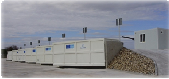
Vista general de Contenedores de residuos no peligrosos
