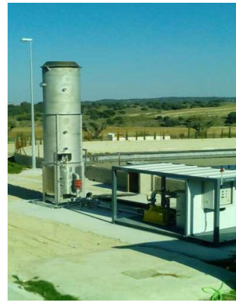
Antorcha de combustión del biogás
