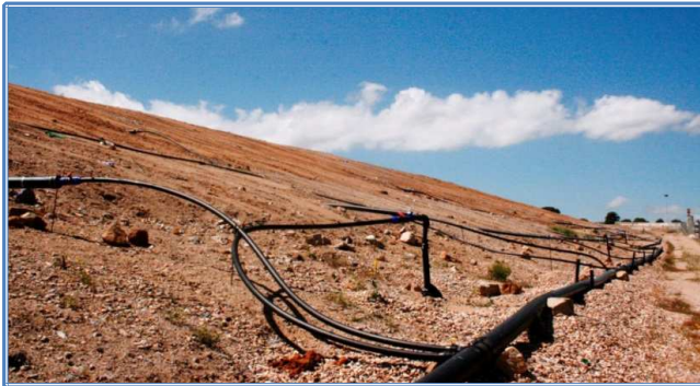
Canalizaciones de Biogas
